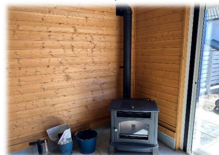
薪ストーブ設置!
