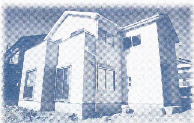
加木屋町現地写真
